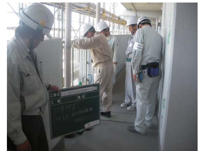
▲工事中の検査風景
