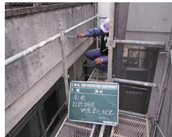
▲工事前の調査風景（打診調査）
